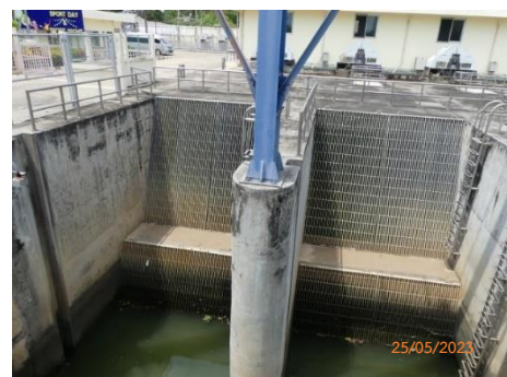
รูปที่ 2.2-19 ตะแกรงช่องรับน้ำ บริเวณสถานีสูบน้ำท่าราบ
