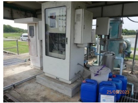
รูปที่ 2.2-10 รายงานสิ่งแวดล้อม และกิจกรรมเพื่อสังคม รูปที่ 2.2-11 เครื่อง BOD/COD Online บริเวณบ่อดักน้ำเสีย
