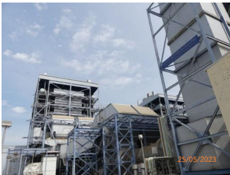
รูปที่ 2.2-4 ระบบกำจัดก๊าซ SO 2 (Flue Gas Desulfurization: FGD)
