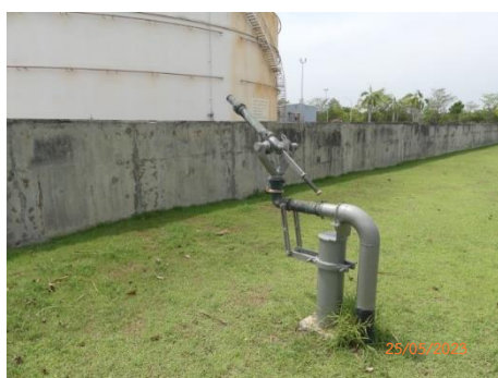
รูปที่ 2.2-38 การติดตั้ง Monitoring Nozzle รอบ Tank Farm
